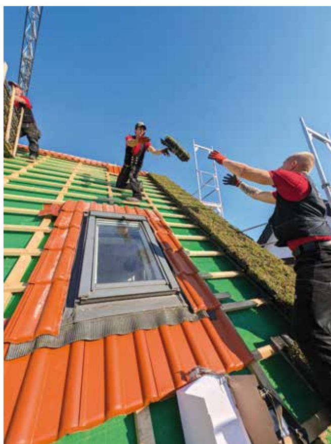
Kevin Springub (rechts) und seine Mitarbeiter verlegen die Dachpfannen mit Begrünung.
